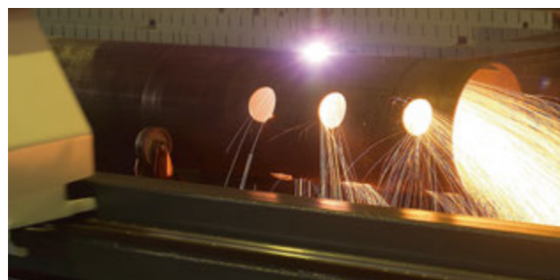
Процесс обработки профильной трубы на установке плазменного раскроя
